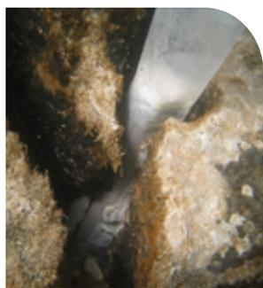
Le ciment CRAS permet d'effectuer des démolitions de roches et de béton sous l'eau, la seule différence s'effectue sur le chargement des trous.
